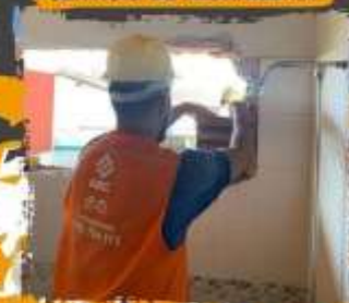
SERVICIO DE ALBAÑILERÍA
