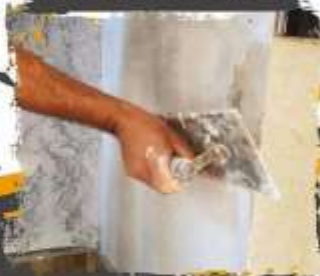
COLOCACIÓN DE ENDUIDO
